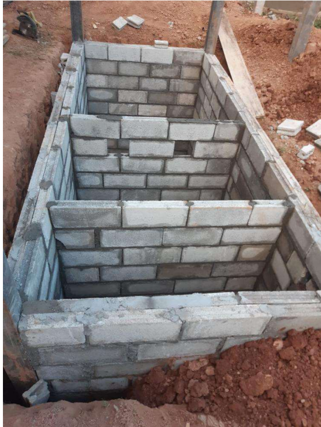
Deux semaines après la fosse septique est terminée
