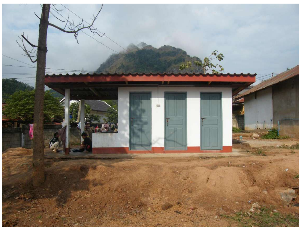
Le troisième bâtiment toilette mis en service fin 2025
