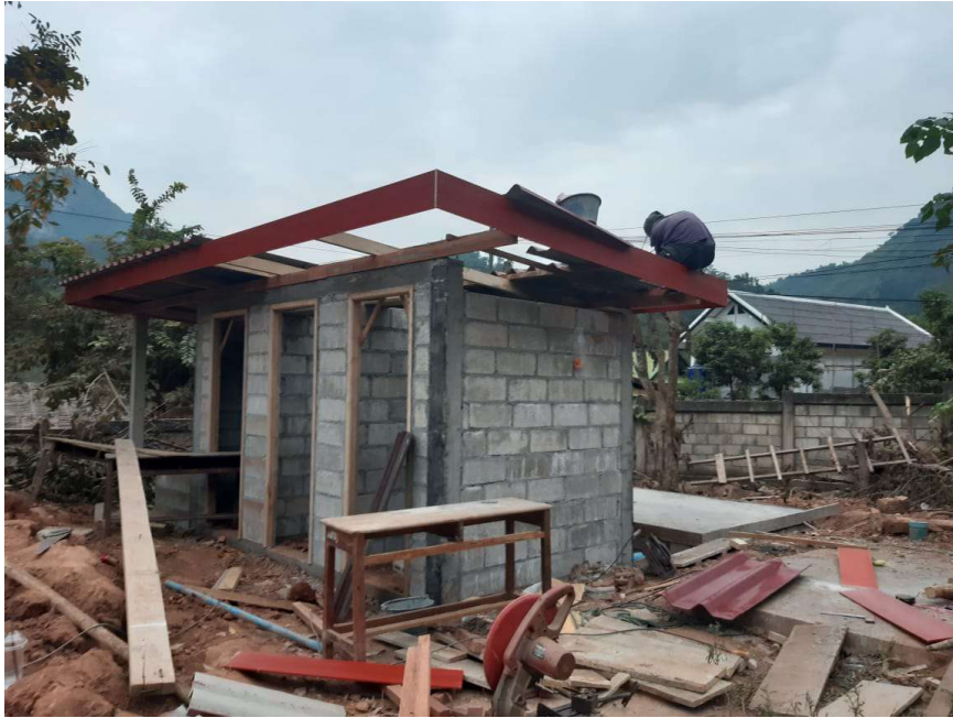
Le troisième bâtiment latrines est en cours de construction
