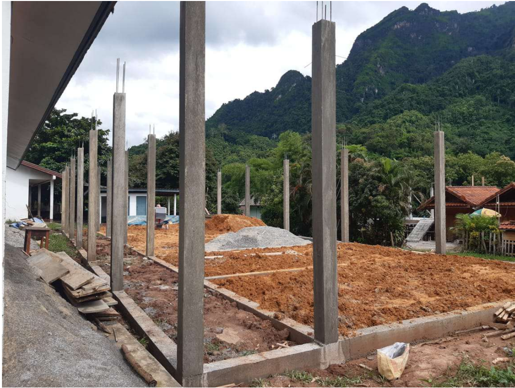
Le chantier le 22 juillet
