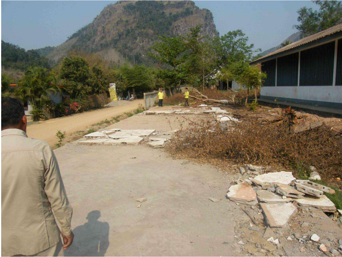
Les arbres sont coupés la surface est en cours de nettoyage.
