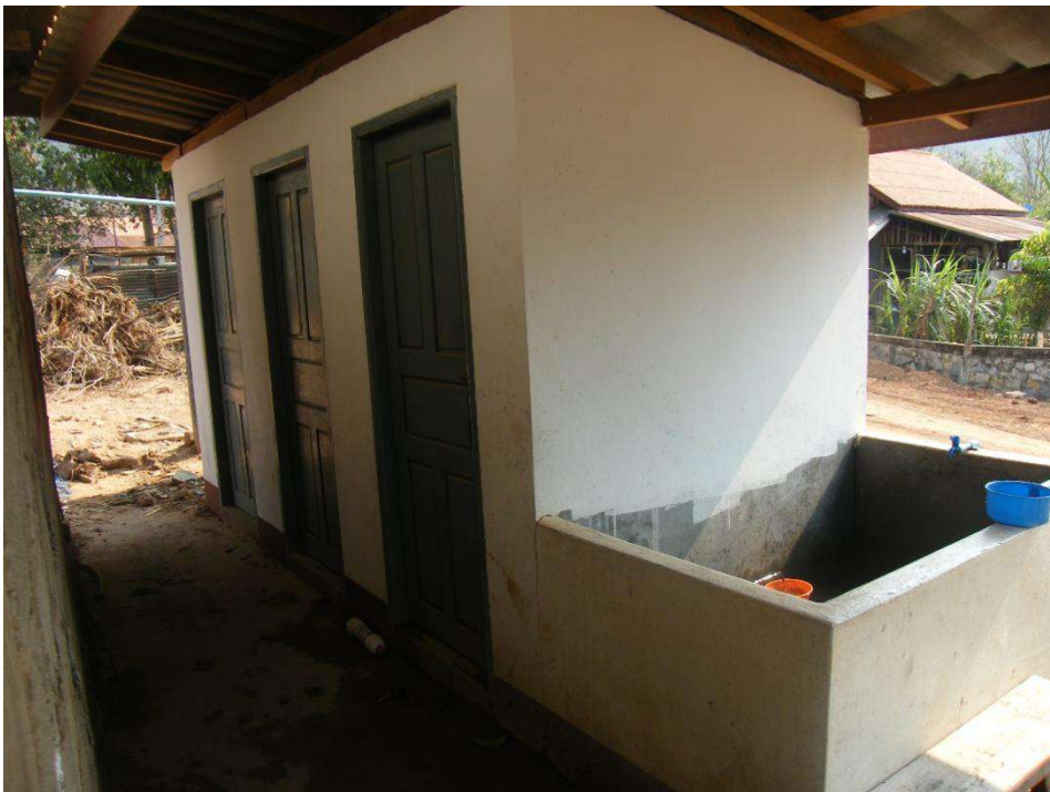
Le bâtiment est terminé et opérationnel vers le 20 novembre
