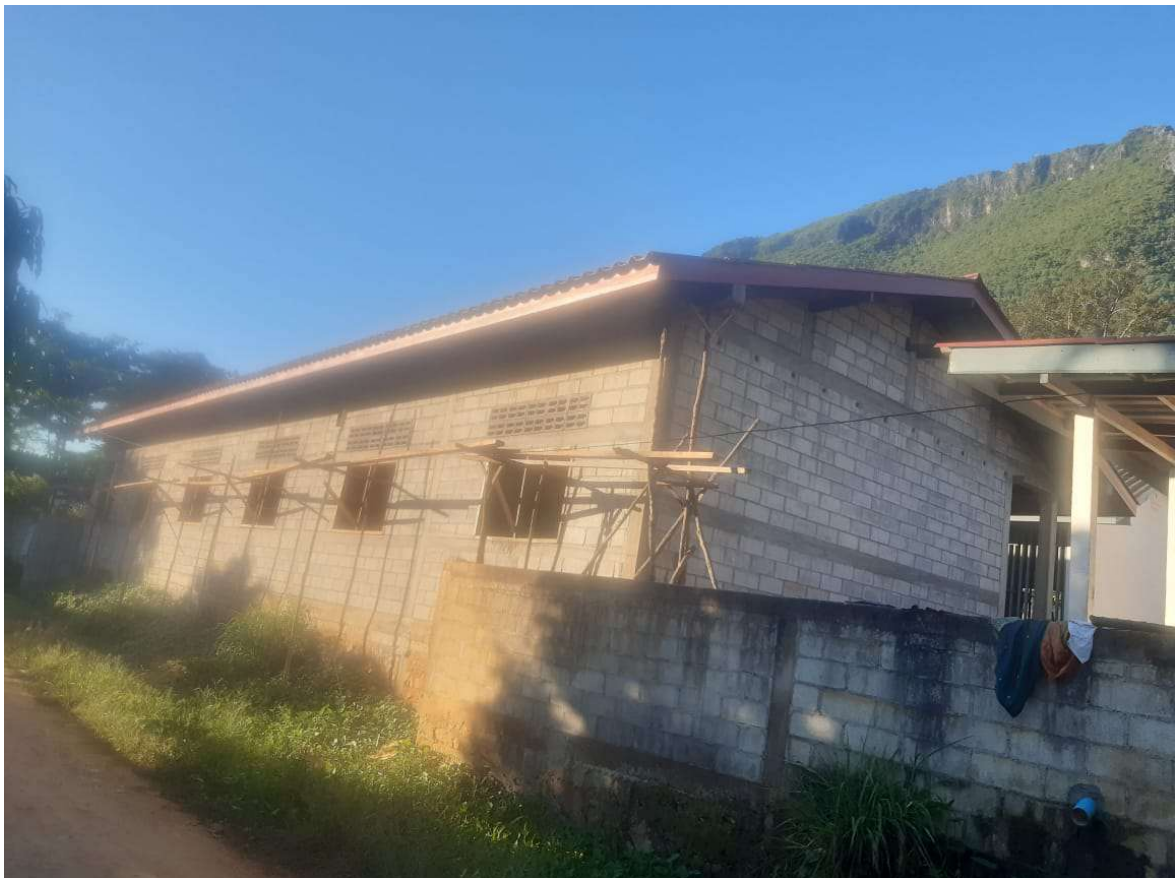
Le chantier le 23 octobre
