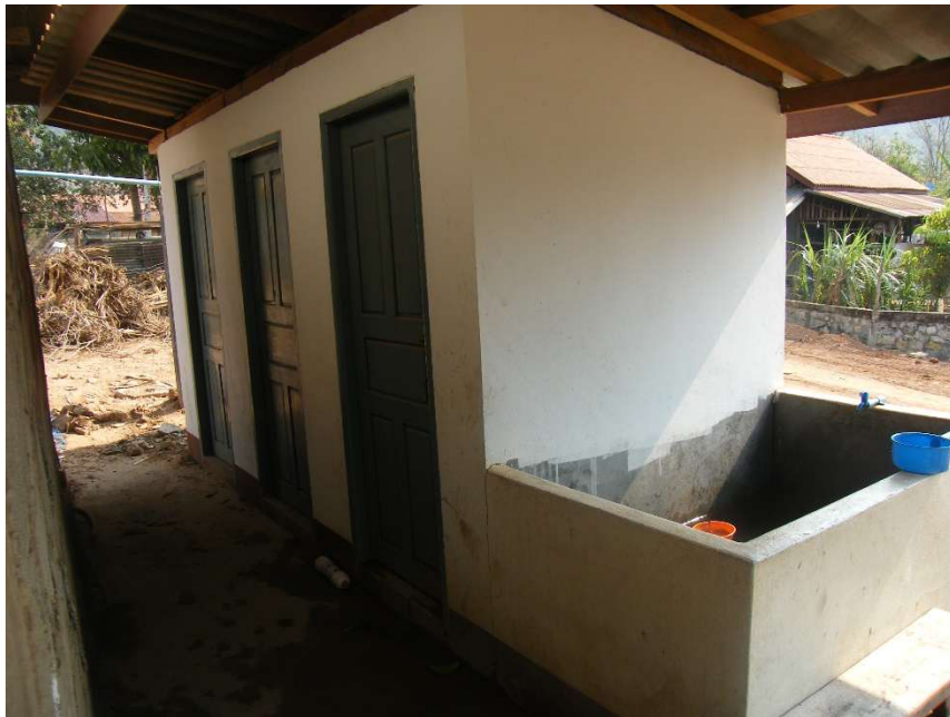
Le premier bâtiment toilette construit en urgence en novembre 2024
