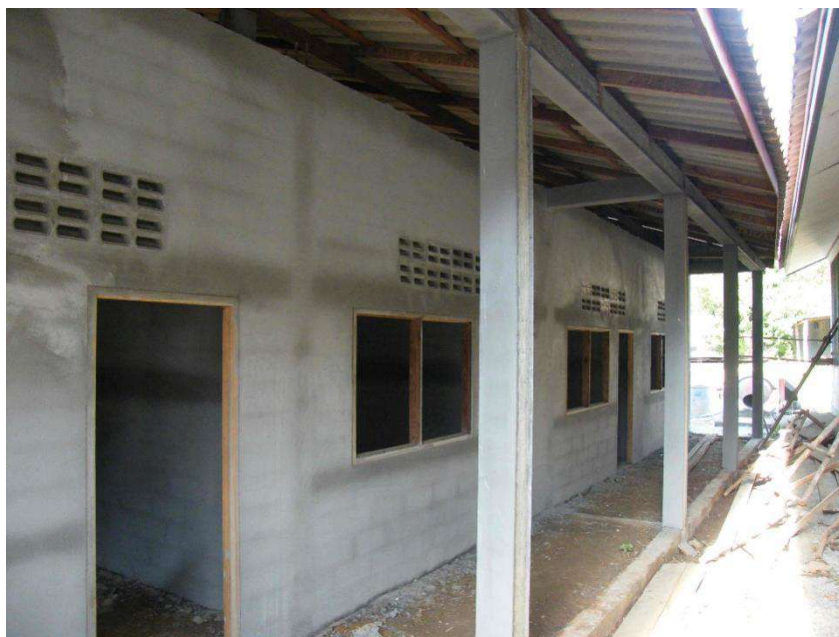
Les crépis sont terminés
