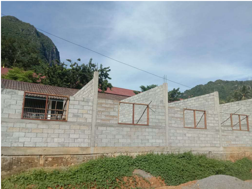
Le chantier le 12 septembre
