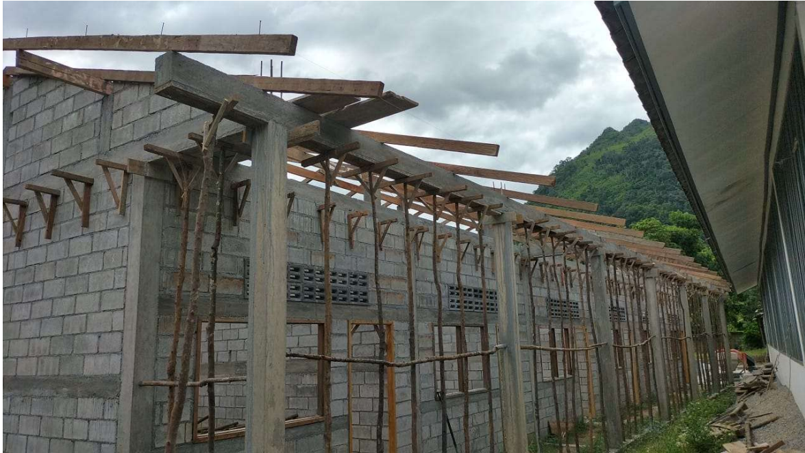
Le chantier 29 septembre
