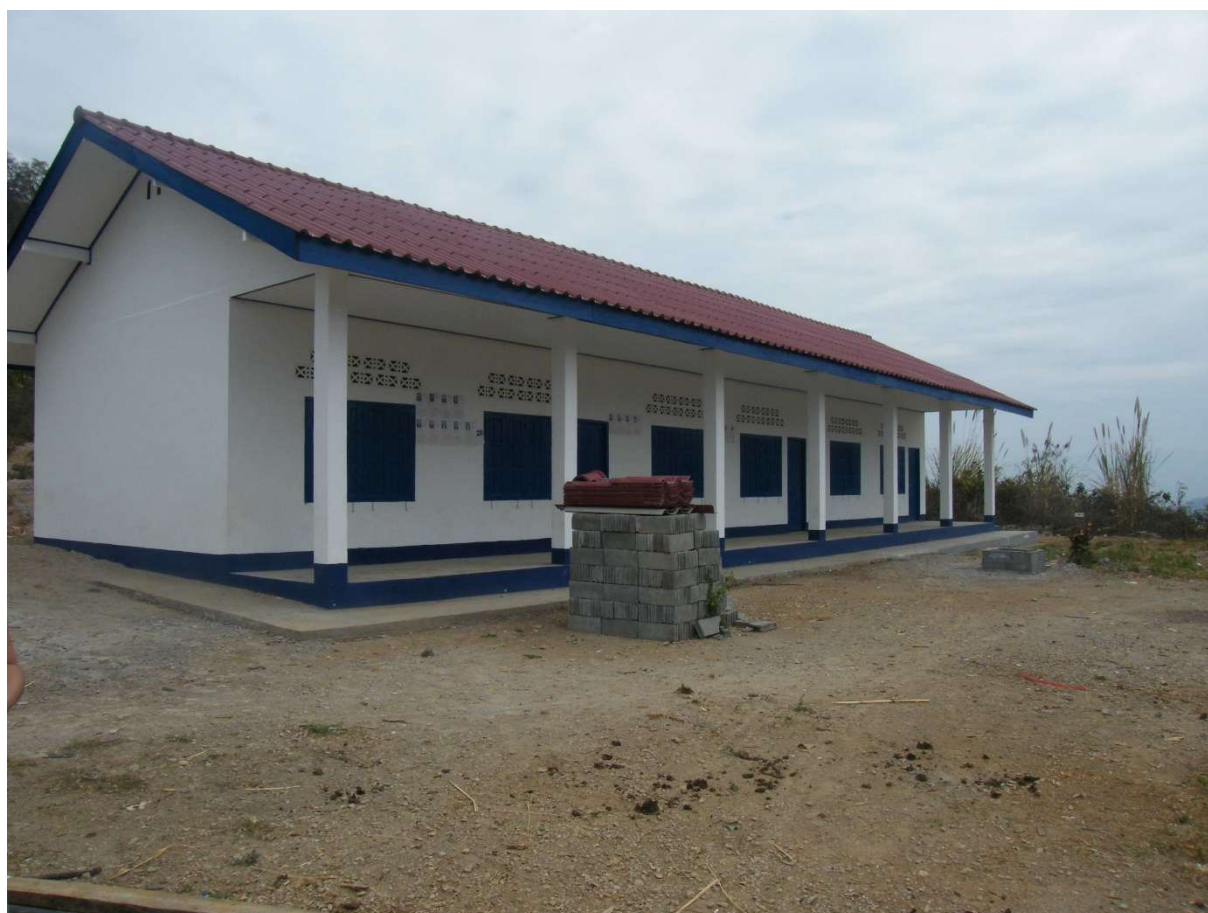
Voici la nouvelle école juste terminée
