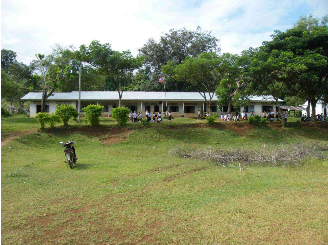
Le bâtiment abritant les 5 classes primaires et un bureau pour les enseignants
